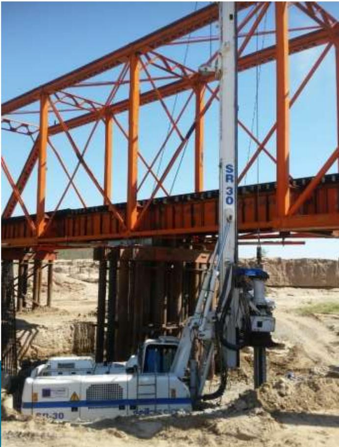
CONSTRUCCIÓN DE DOS PILAS DE CONCRETO ARMADO A BASE DE PILOTES COLADOS EN EL LUGAR, Y ADECUACIÓN DE DOS APOYOS EN DOS CORONAS DE MAMPOSTERÍA EN EL PUENTE DE FERROCARRIL M-648+89. AGOSTO -DICIEMBRE 2017
